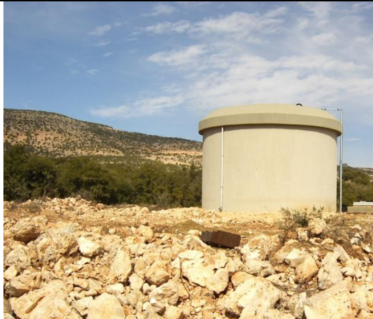
Le réservoir tampon (régulateur)
