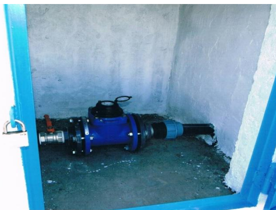
Compteurs d'eau dans un compartiment protecteur à chaque vanne des exploitations agricoles
