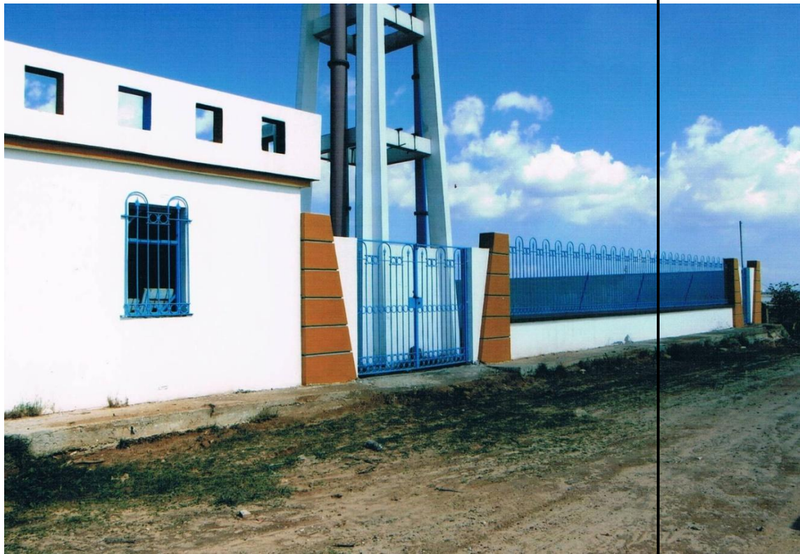
Réhabilitation du château d'eau
