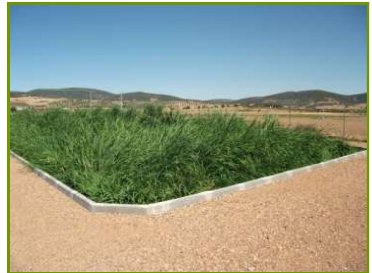
WWTP Los Cortijos (Ciudad Real) (FMF)
