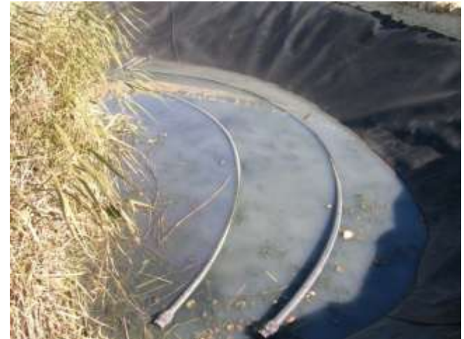
Encrassement dans les zones humides artificielles horizontales
