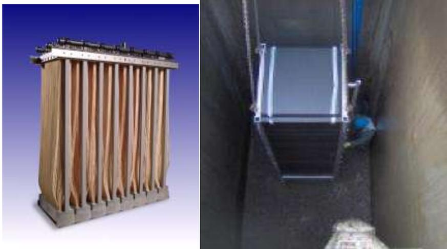
FIGURE 4-2 ZENON ZEEWEE MEMBRANE CASSETTE USED IN BEN GURION WWTP PROJECT
