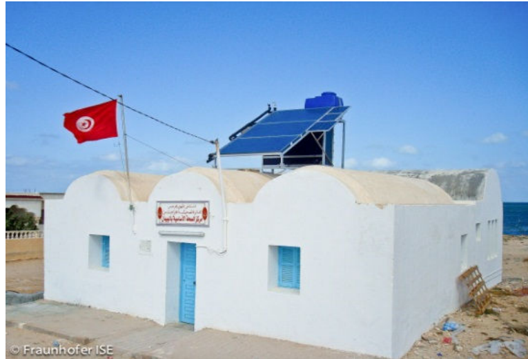
Figure 21 : Unité Solar Spring Oryx 150 installée sur le toit d'un centre de santé dans une zone rurale de Tunisie.
