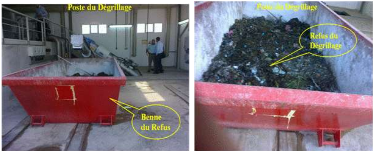
Figure 8. Poste de dégrillage
