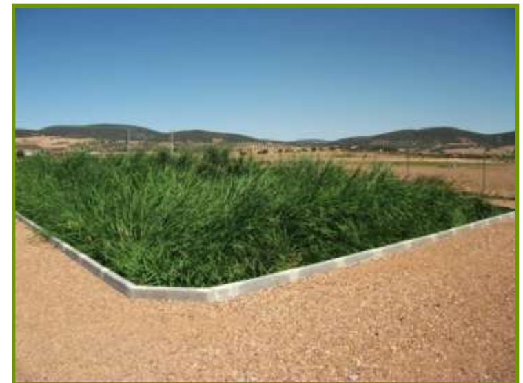
WWTP Los Cortijos (Ciudad Real) (FMF)
