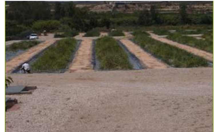
Fabara WWTP (Zaragoza) (FHS)
