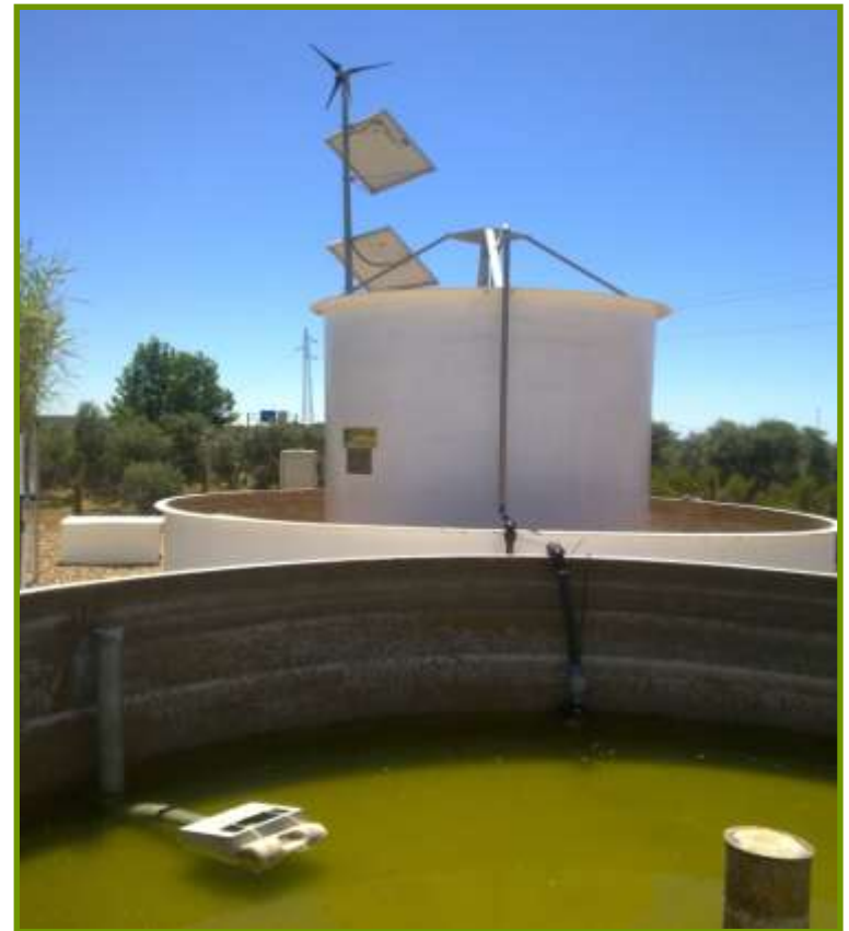
Épaisseur du filtre substrat: 1,5 m
