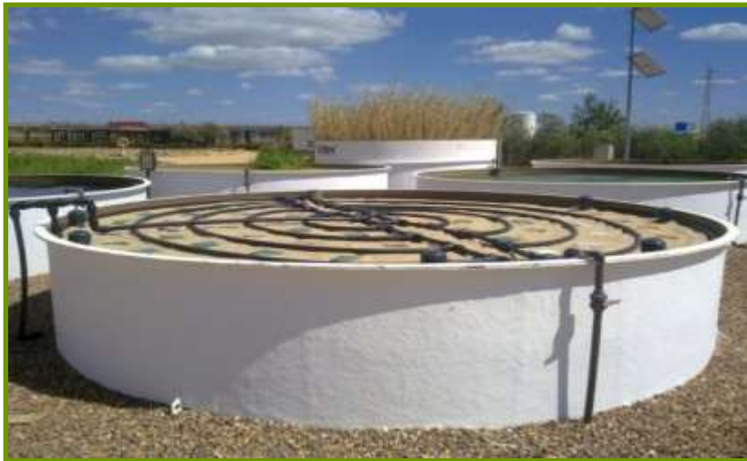
Épaisseur du filtre substrat: 0.6 m
