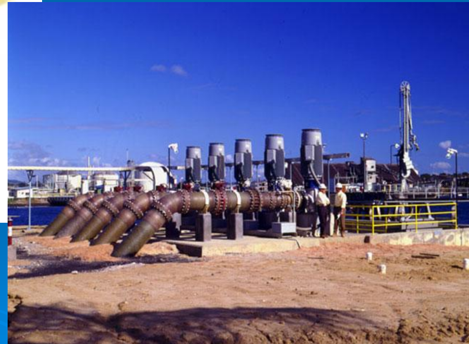
Prise d'entrée littoral - Unité de dessalement Point Lisas, Trinité
