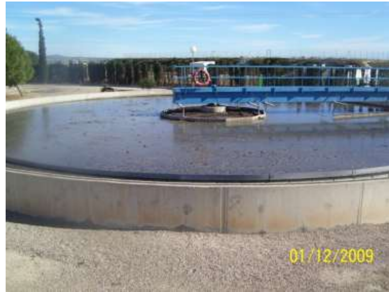
Mousse filamenteuse dans un réacteur biologique et bassin de sédimentation secondaire.
