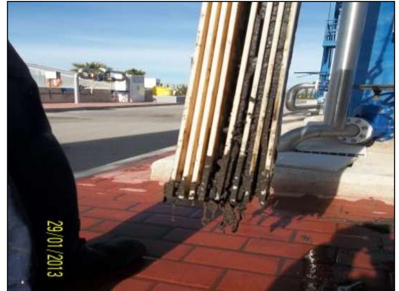
Bouchage des membranes plates et formation de boue
