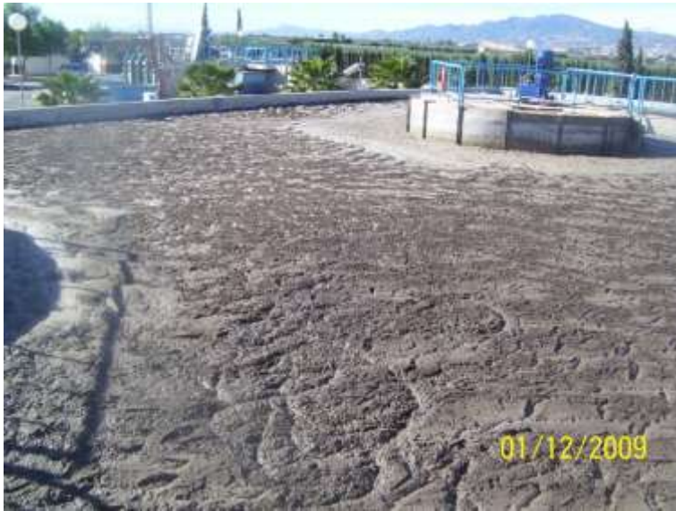
Mousse filamenteuse dans un réacteur biologique et bassin de sédimentation secondaire.
