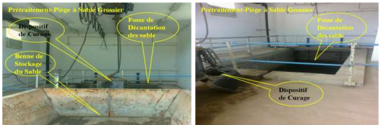
Figure 7. Le piège à sable
