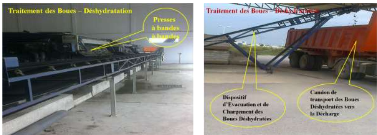
Figure 15. Les ouvrages pour la déshydratation des boues
