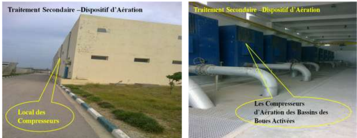
Figure 12. Les dispositifs d'oxygénation des réacteurs biologiques
