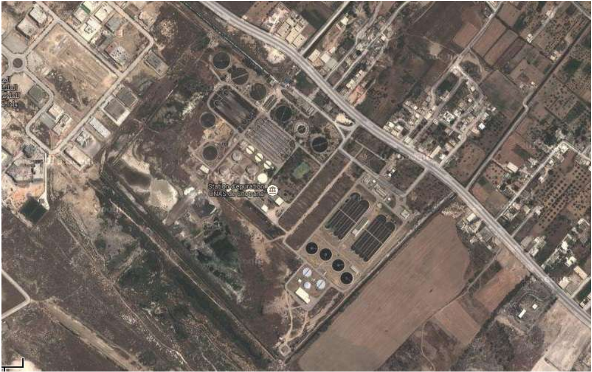
Figure 2. Vue aérienne des STEPs de Choutrana 1 (gauche) et 2 (droite)
